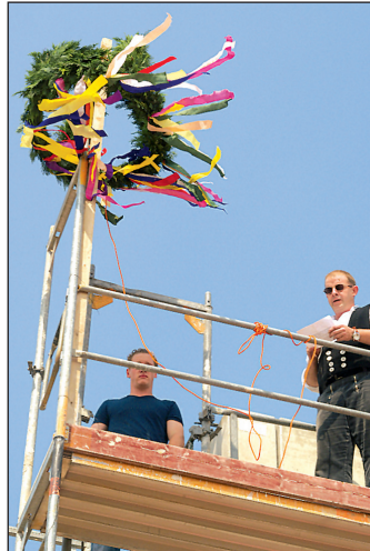
Zimmerermeister Stefan Fiehn sprach den Richtspruch und wurde dabei assistiert durch den Azubi Florian Battermann.
